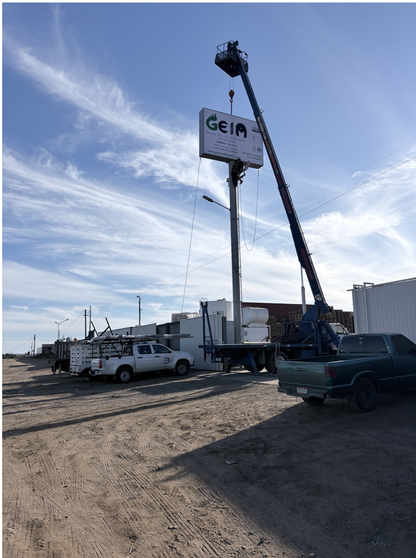
Montaje especializado utilizando grúa y estructuras metálicas reforzadas.
